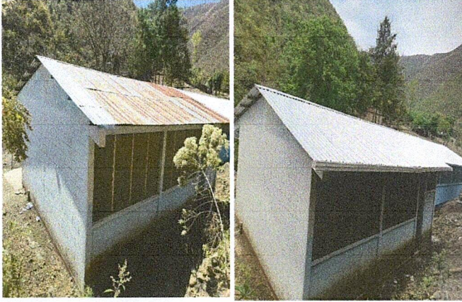
Foto 1: MEJORAMIENTO DE TECHO A LAMINA TROQUELADA CALIBRE 26 Y MANTENIMIENTO DE ESTRUCTURA PORTANTE
