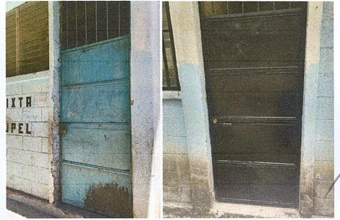
Foto 4: MEJORAMIENTO E INSTALACION DE PUERTAS
