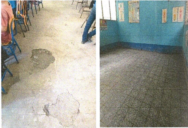
Foto 3: MEJORAMIENTO DE PISO E INSTALACION TIPO CERAMICO O GRANITO
